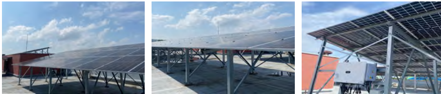
대동기어 본관동 옥상 태양광 발전설비 설치 과정 및 설치 전경
